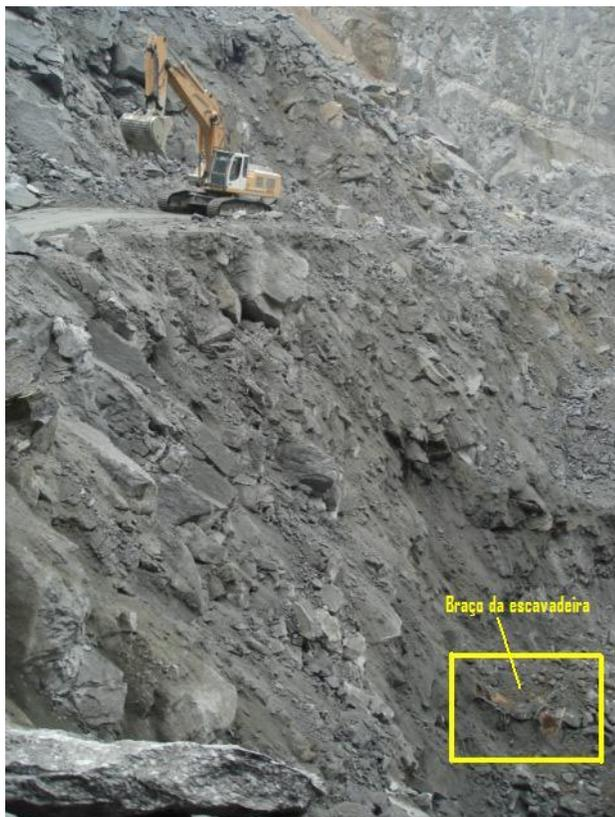
Foto 2. Foto do local mostrando parte da escavadeira mapeada pelo método de magnetometria e revelada após escavação.
